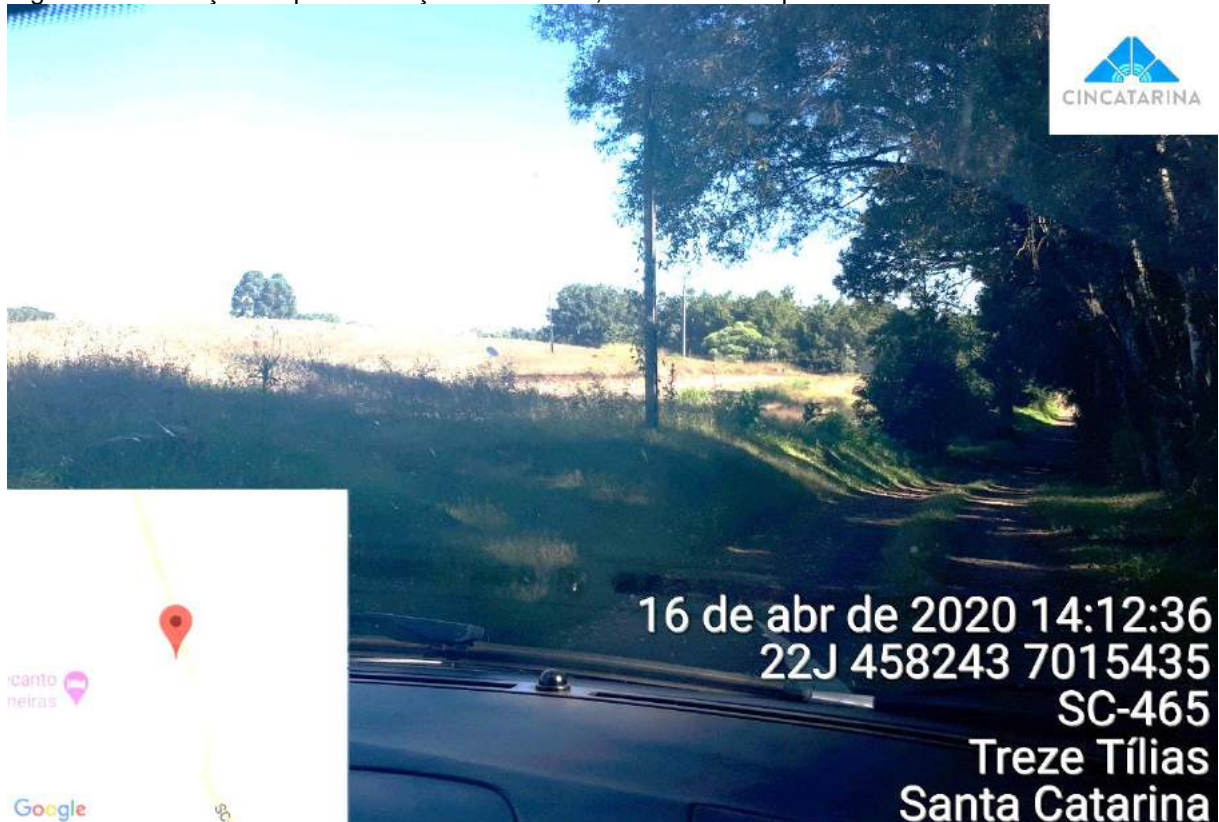
Figura 26- Condição da pavimentação na SC-465, sentido município de Salto Veloso.
